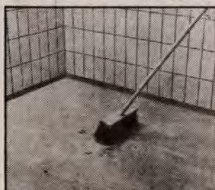
21. ábra Az alapot gondosan meg kell tisztítani a burkolás megkezdése előtt.
