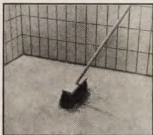
32. ábra A felületet a munkakezdés előtt alaposan megtisztítjuk.
