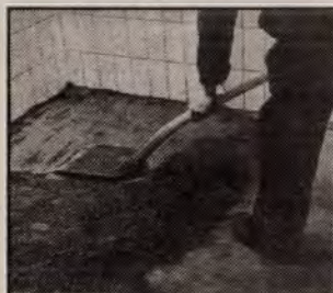
23. ábra Terítsük szét a fektetőhabarcscot és tömörítsük gondosan. Ne terítsük szét több habarcscot egyszerre, mint amennyi 4-5 sorhoz szükséges.
