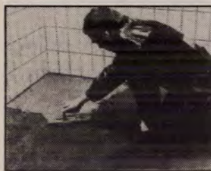
25. ábra A fektetőhabarcscra folyékony cementiszapotot (cement és víz) terítsünk.
