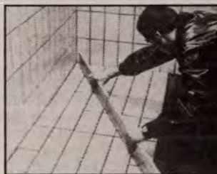
28. ábra Minden újonnan burkolt rész felületének egyenletességét gondosan kell ellenőrizni fektetődeszka segítségével és amennyiben szükséges, el kell végezni az igazításokat.
