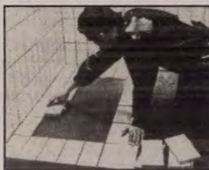
26. ábra Amint a felesleges víz felszívódott a habarcscba, és az iszap felülete matt lesz, megkezdjük a lapok fektetését a fektetődeszka jelölései szerint.
