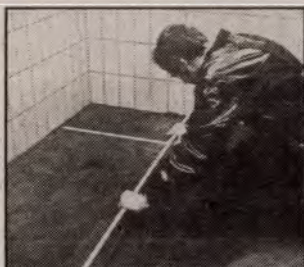
24. ábra Helyezzük el a vezetőléceket 2-3 m közöttben, vagy bármely más távolságban, amely a burkolandó felület tekintetében megfelel. A habarcscot a vezetőlécek szerinti megfelelő magasságban kell szétteríteni.
