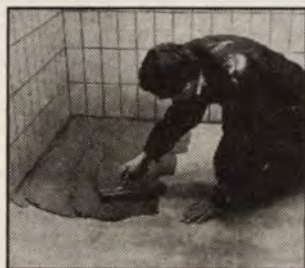
33. ábra A ragasztót a csomagoláson megadott utasítások szerint alkalmazzuk. Spatulyát vagy acél simítólapot használjunk.
