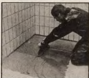
34. ábra Az anyag szétterítésére fogazott éllel ellátott spatulyát használunk. A spatulyát az alapra merőlegesen kell tartani. Egyszerre legfeljebb 4-5 lapsorhoz szükséges anyagot terítsünk fel.
