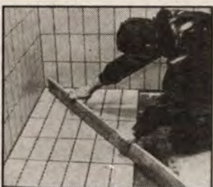
34. ábra Az anyag szétterítésére fogazott éllel ellátott spatulyát használunk. A spatulyát az alapra merőlegesen kell tartani. Egyszerre legfeljebb 4-5 lapsorhoz szükséges anyagot terítsünk fel.
