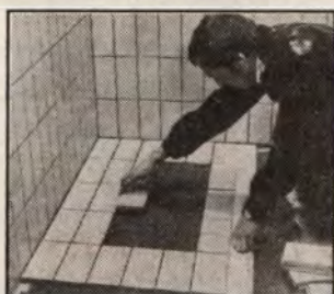
35. ábra A lapokat a fektetődeszka jelöléseinek megfelelően helyez-zük le, majd benyomkodjuk a ragasztóanyagba, mégpedig 15 perccel az anyag felterítése után.
