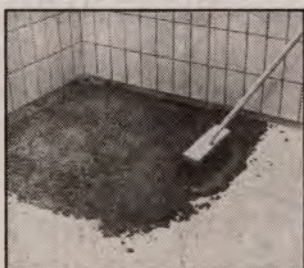
22. ábra A cementiszapot a lapok fektetése előtt kefével kell a felületbe bedolgoztatni.
